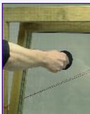
Zugseil schräg nach unten verlegen und das Fenster zuziehen
