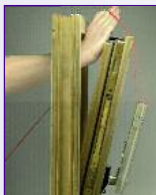
Zugseil über das Verriegelungsgestänge verlegen
