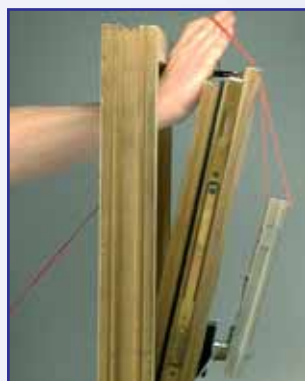
Zugseil über das Verriegelungsgestänge verlegen
