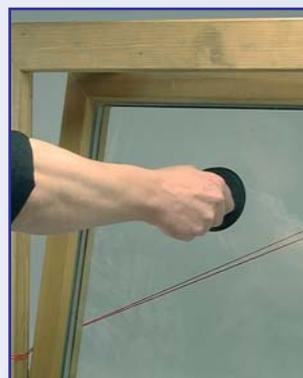
Zugseil schräg nach unten verlegen und das Fenster zuziehen
