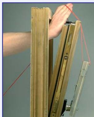
Zugseil über das Verriegelungsgestänge verlegen
